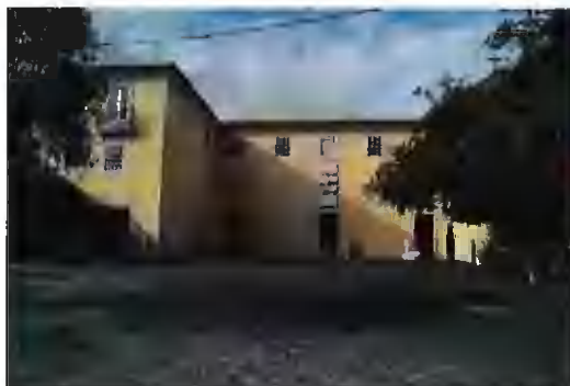
Fachada nascente e corpo da livraria conventual
