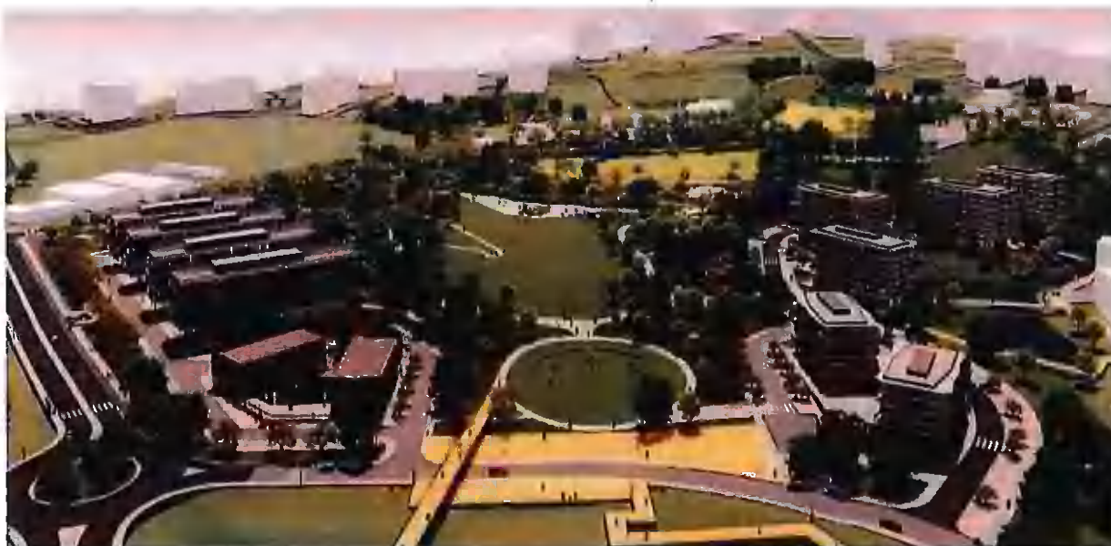
FIGURA 8 – Vista geral, Unidade de Execução – Encosta do Conventinho, Anexo 3 – Memória Descritiva, pág. 1.
