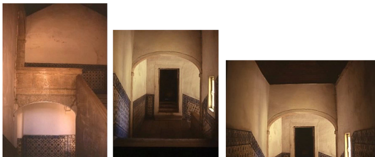
Escadaria: guarda em pedra, arcos abatidos
