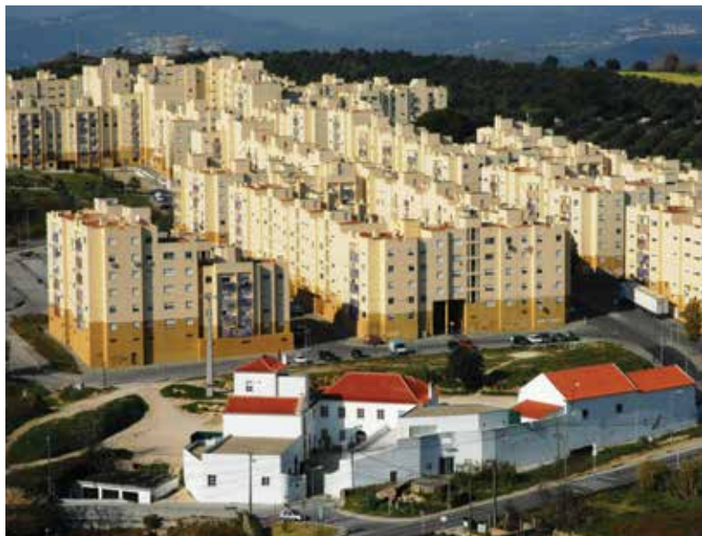
Remodelação de edifícios e modernização de espaços exteriores
