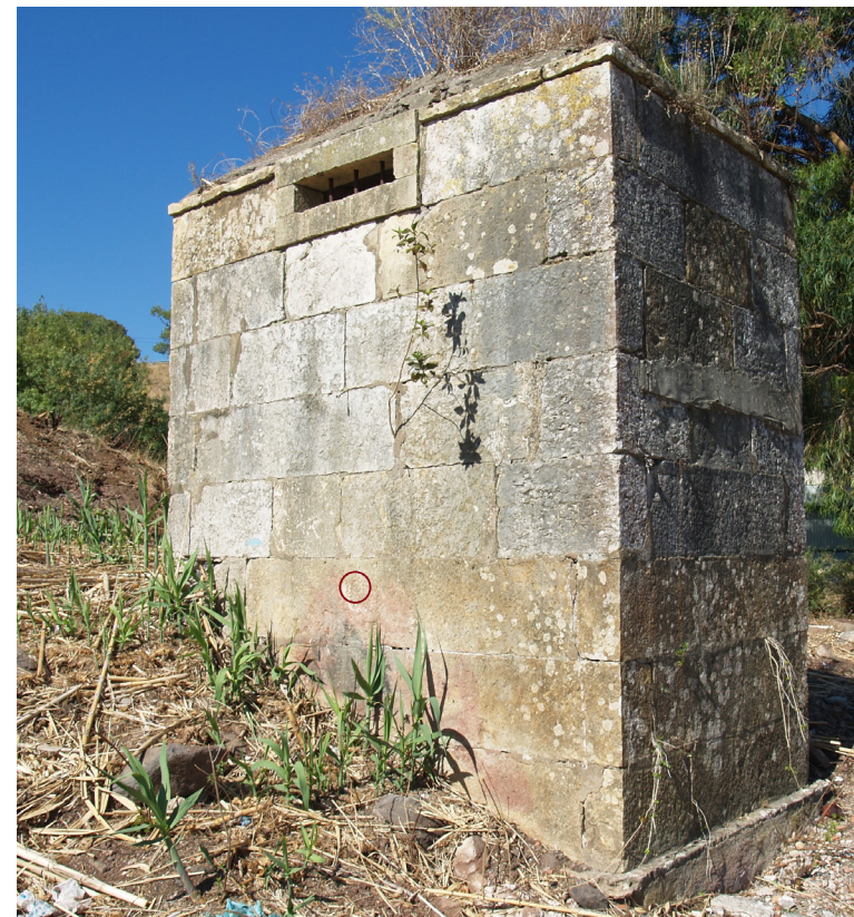
Claraboia do Aqueduto de Loures, com sinalização de um círculo gravado na silharia, correspondente a uma sigla de pedreiro/canteiro.
